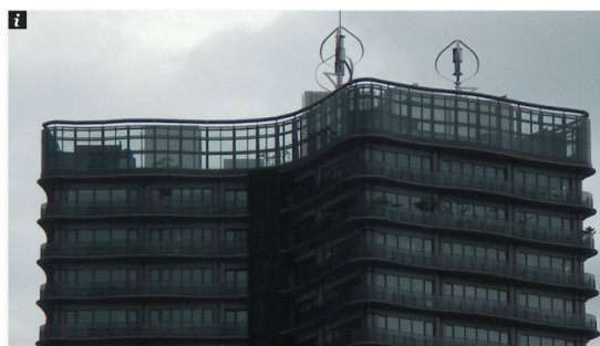
Fig. 26 - Unidade DS 3000 instalada em prédio em Taiwan.
